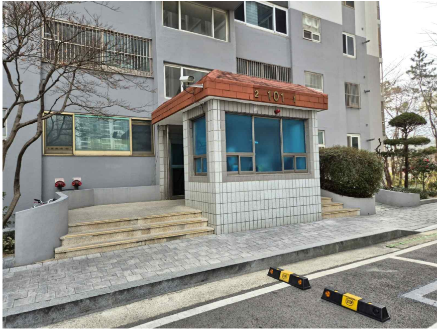
1층 출입구 전경
