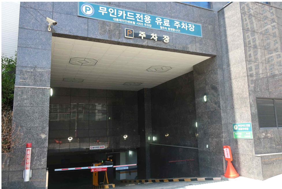
본건 주차장 출입구 전경
