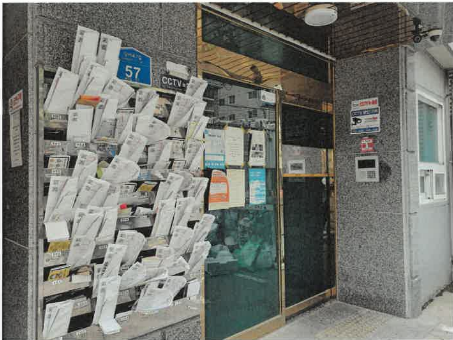
본건 건물 1층 공동출입구
