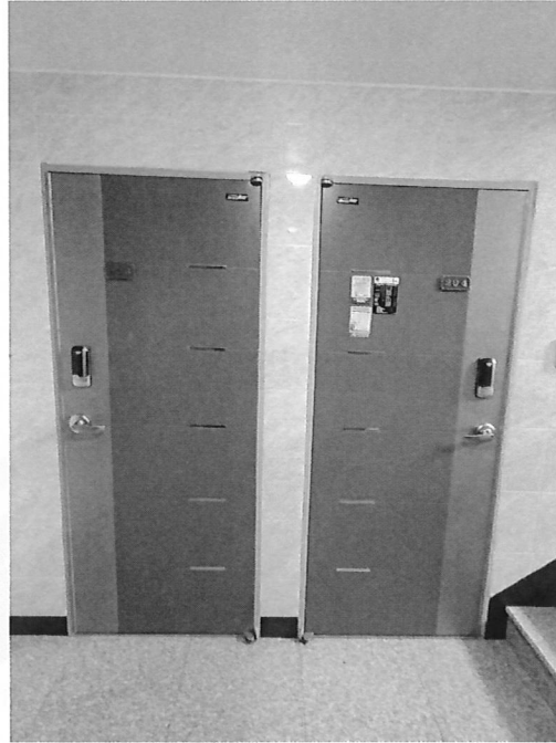
2층 203,204호 출입문
