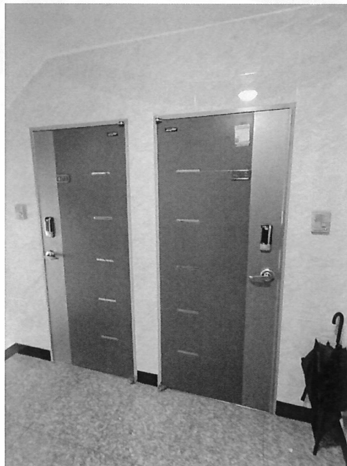
4층 401,402호 출입문
