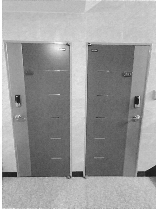
3층 303,304호 출입문
