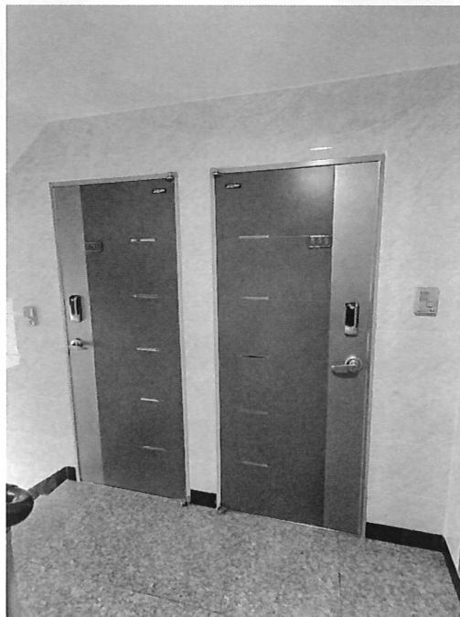
5층 501,502호 출입문
