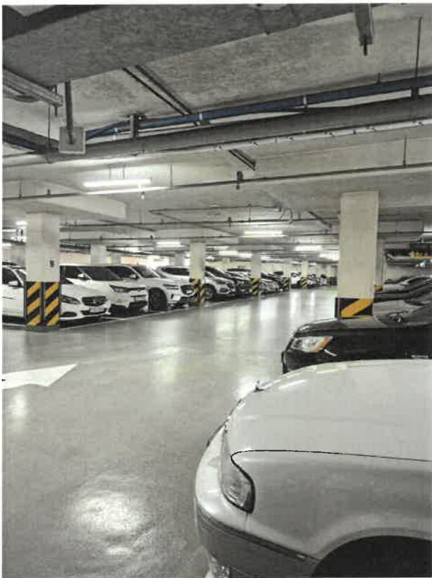
본건 단지내 지하 주차장
