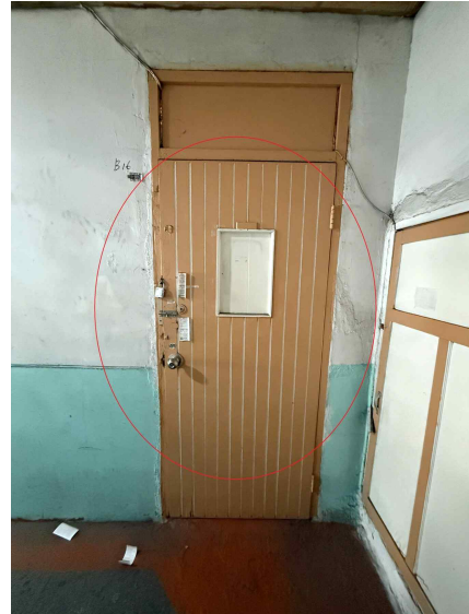
본건 출입문 전경
