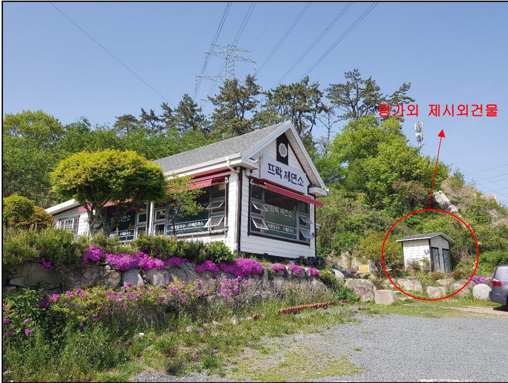
[기호(2): 타인소유 제시외건물, 철탑 및 송전선 부분 (남서 → 북동)]
