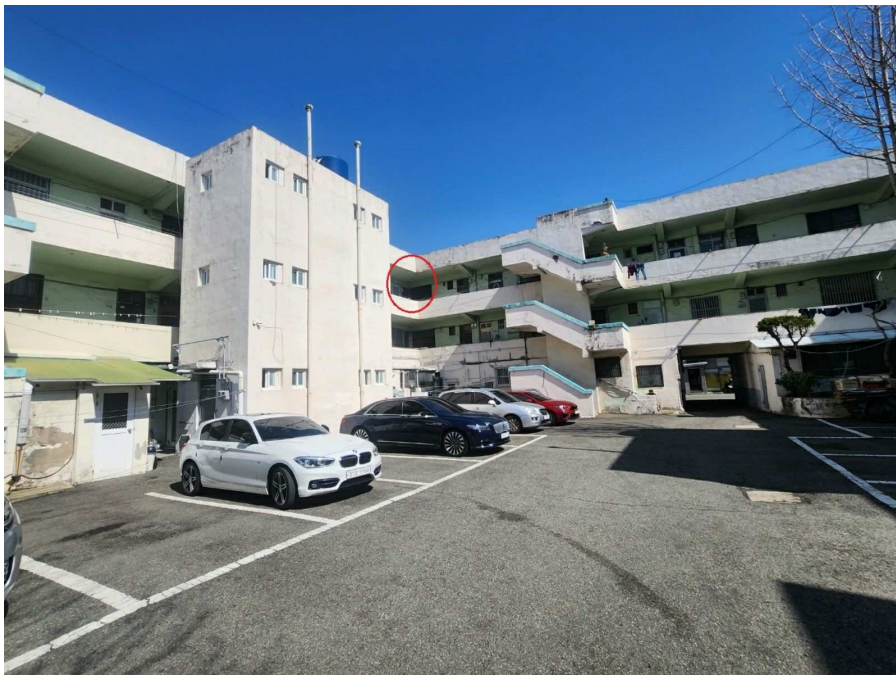
단지 내 3층 108호(현청 3층 308호) 전경
