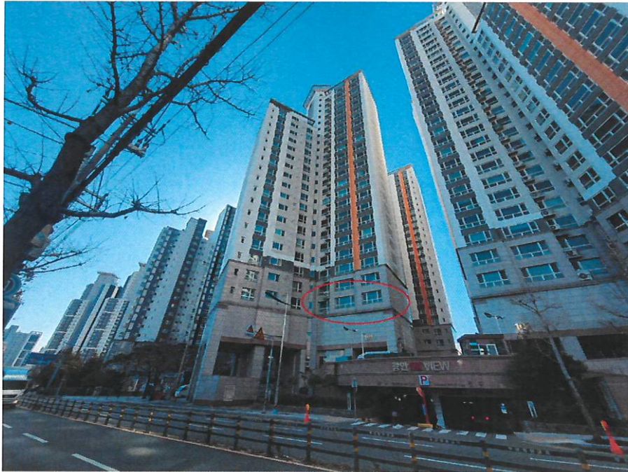
본건 전경 및 제101동 전체전경
