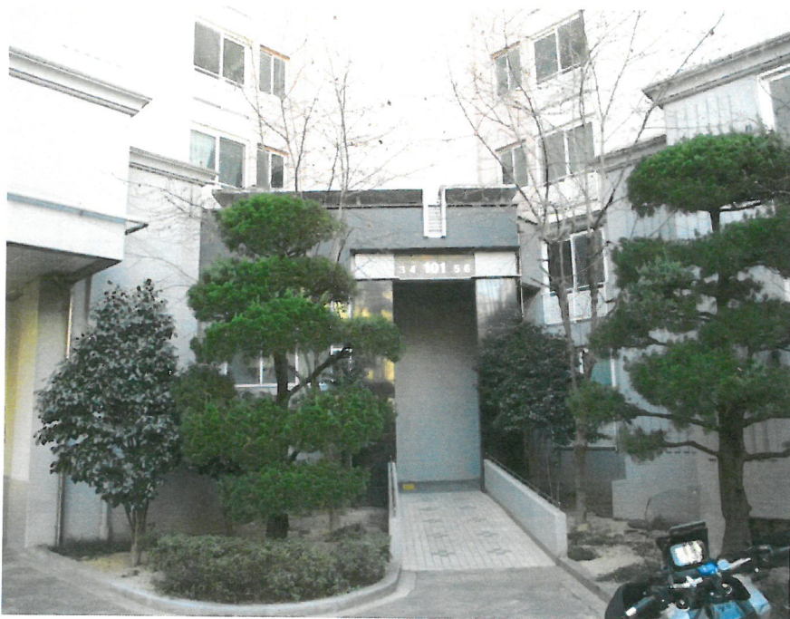
대상물건 출입구 - 전경
