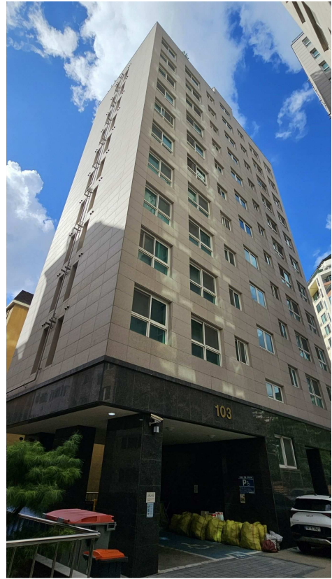
< 남동측에서 본 본건 소재 건물 전경 >
