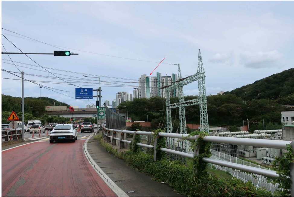
본건 및 주변 전경(1)
