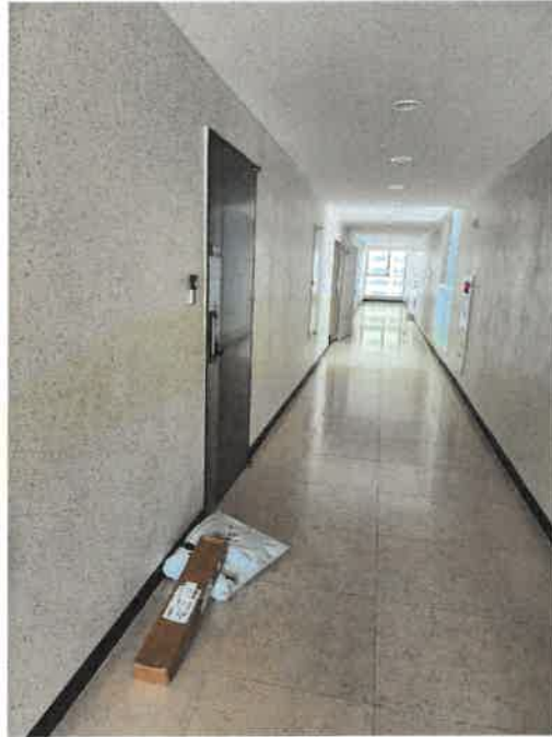
13층 복도 전경
