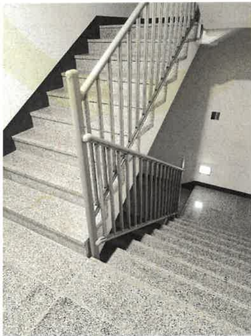
각층 공동 비상계단 전경
