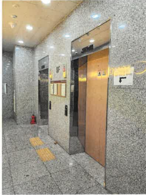
본건 1층 공동엘레베이터 전경
