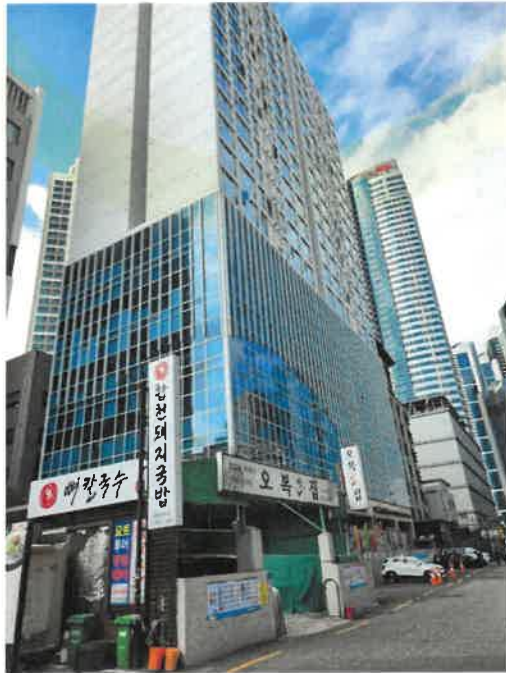
본건 외부전경(남동측 후면도로변에서 촬영)
