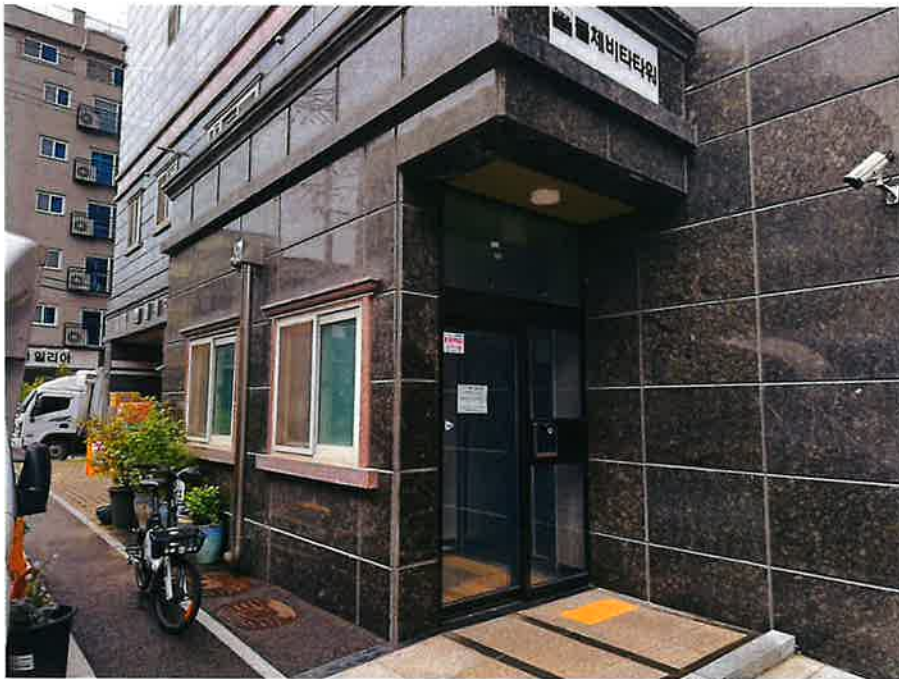
공동 현관 전경
