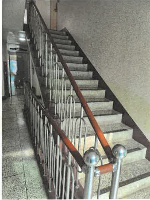
각층 공동 비상계단 전경
