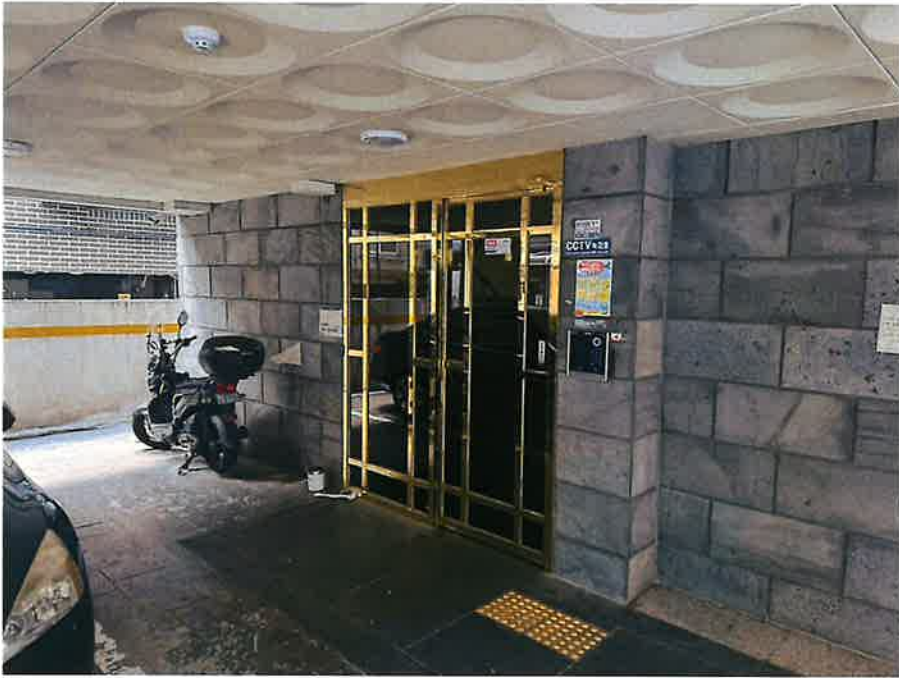
공동 현관 전경
