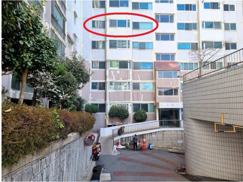
본건 서측 전경 (5층 508호)
