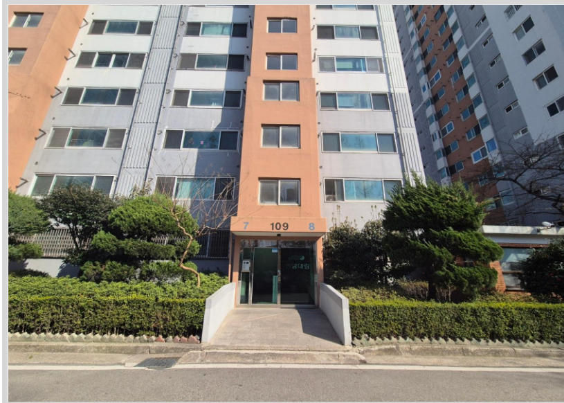
본건 건물 입구 전경
