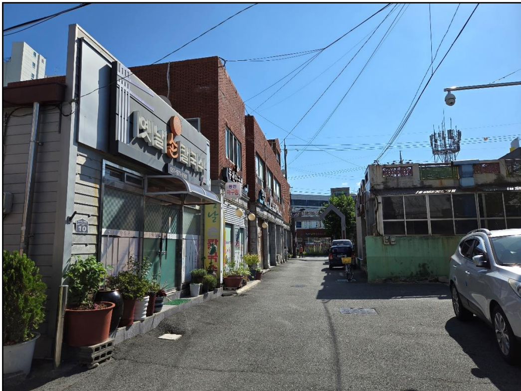
[본건 및 주변 전경 (북동 → 남서)]
