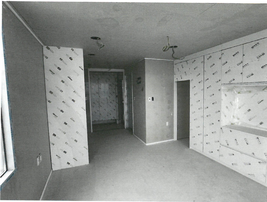
대상물건 내부 전경(2호라인)
