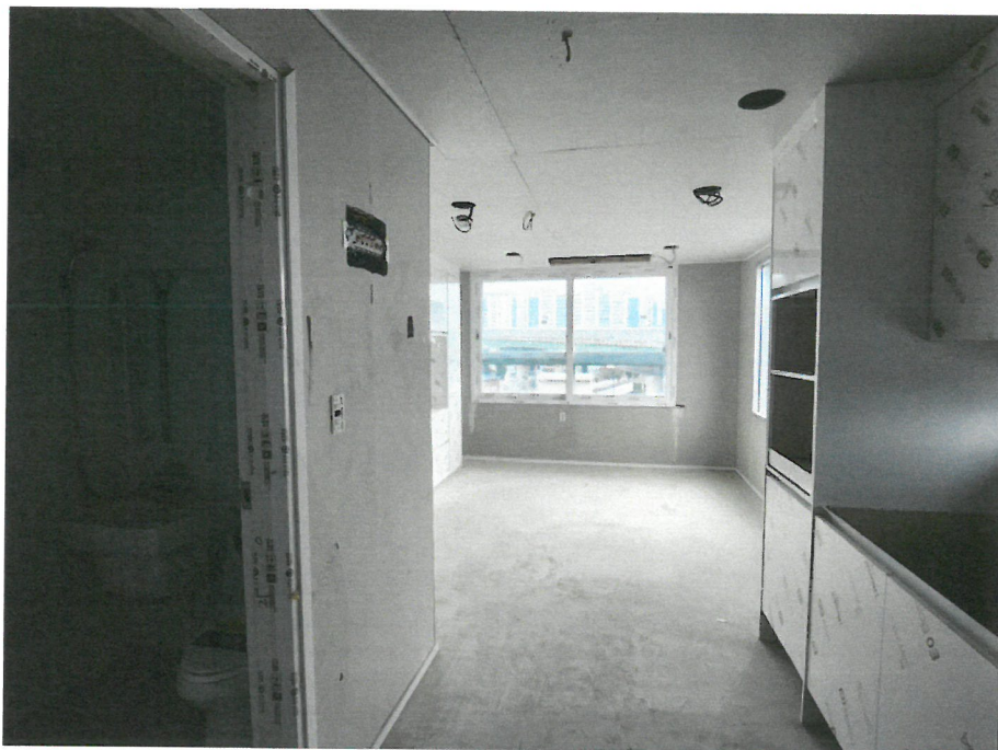
대상물건 내부 전경(2호라인)
