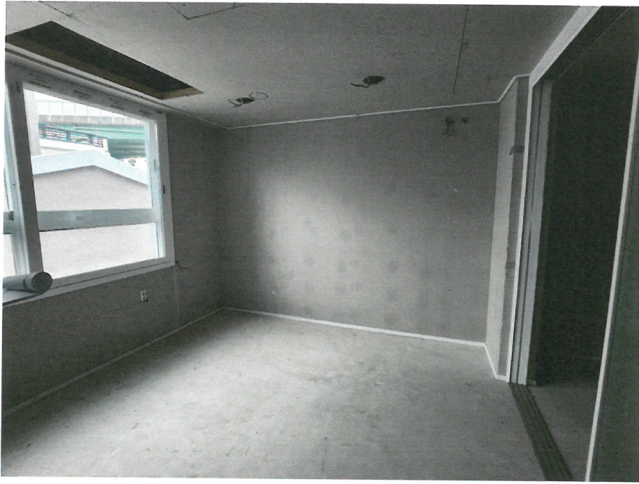
대상물건 내부 전경(1호라인)
