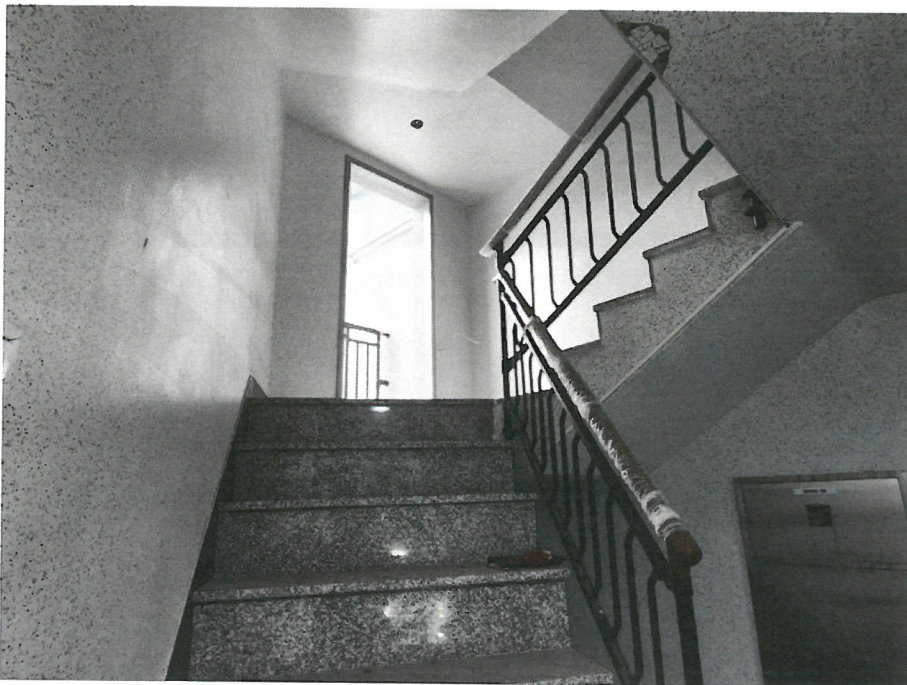
대상물건 계단실 전경
