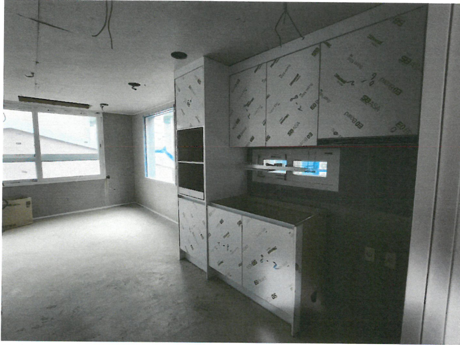
대상물건 내부 전경(2호라인)
