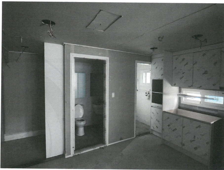
대상물건 내부 전경(1호라인)
