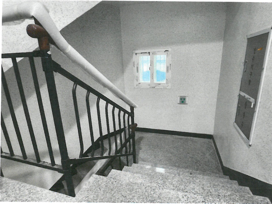
대상물건 계단실 전경
