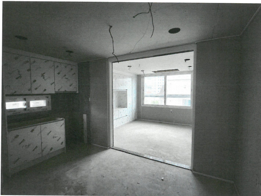
대상물건 내부 전경(1호라인)
