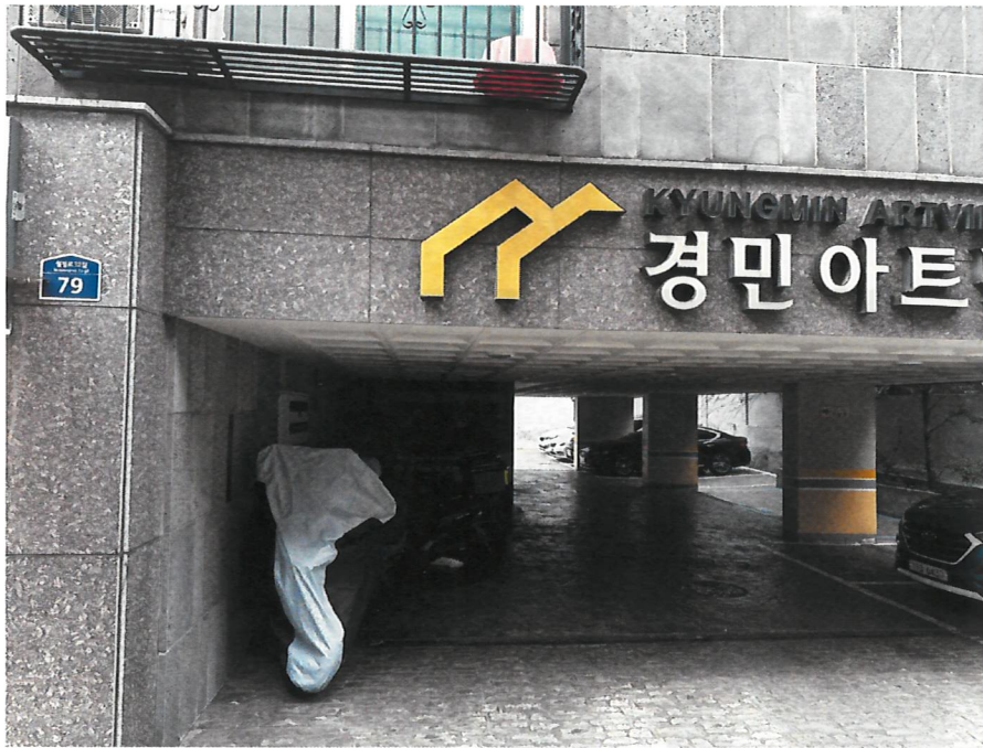
1층 주차장 전경
