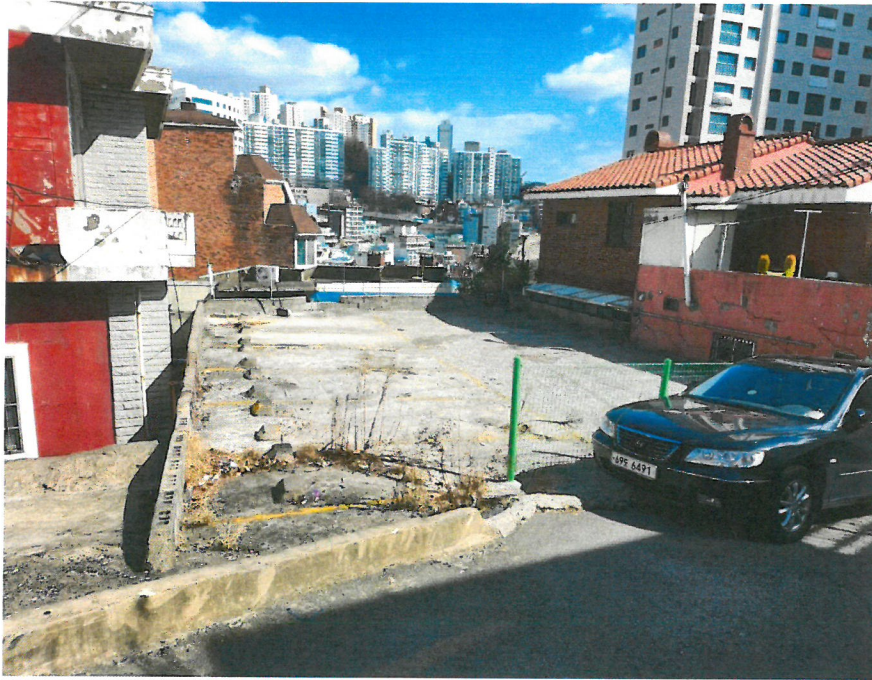
대상물건 일련번호(5) 전경
