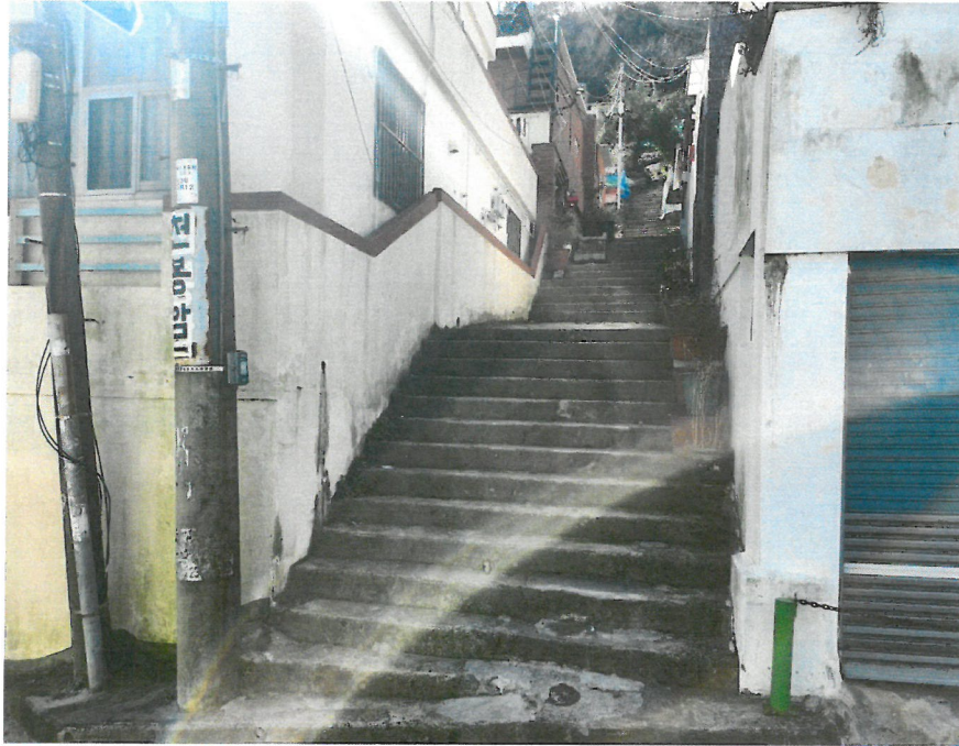
대상물건 일련번호(7) 전경
