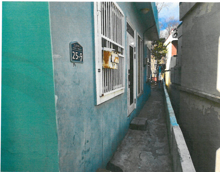
대상물건 일련번호(6) 전경
