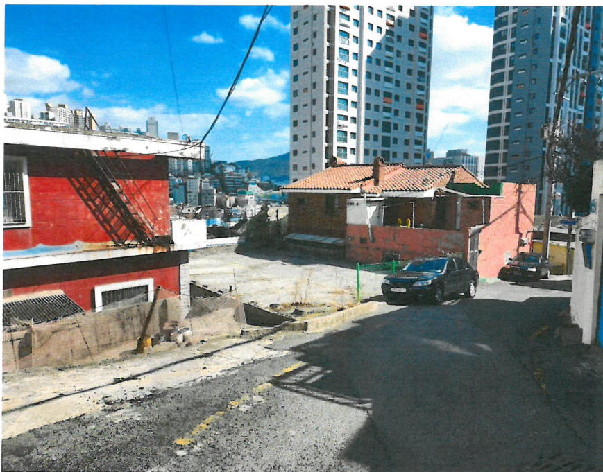
대상물건 일련번호(5) 전경
