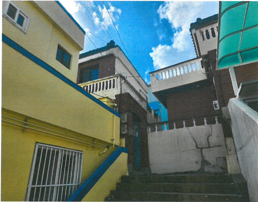
대상물건 일련번호(4) 전경
