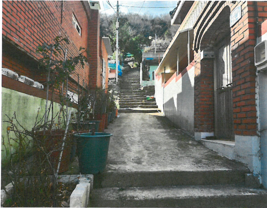
대상물건 일련번호(1) 전경
