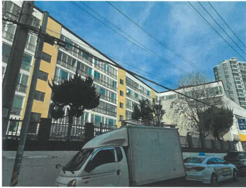
본건 외부 전경
