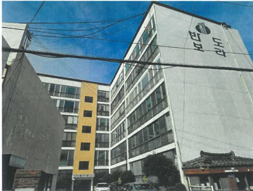
본건 외부 전경
