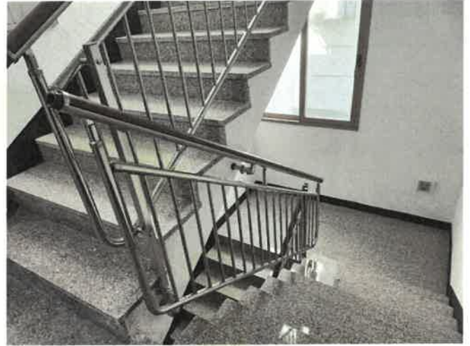
각층 공동 비상계단 전경
