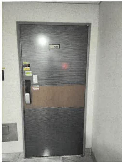
본건 출입문 전경
