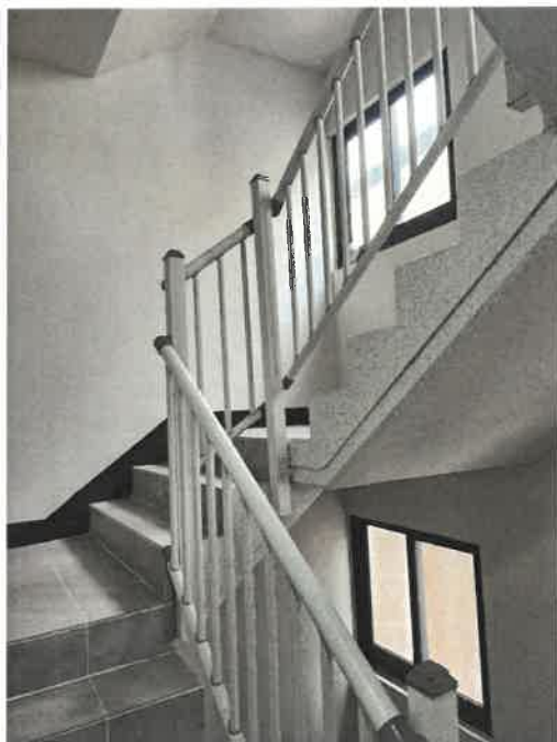
각층 공동비상계단 전경
