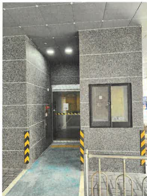
본건 1층 공동출입문 전경
