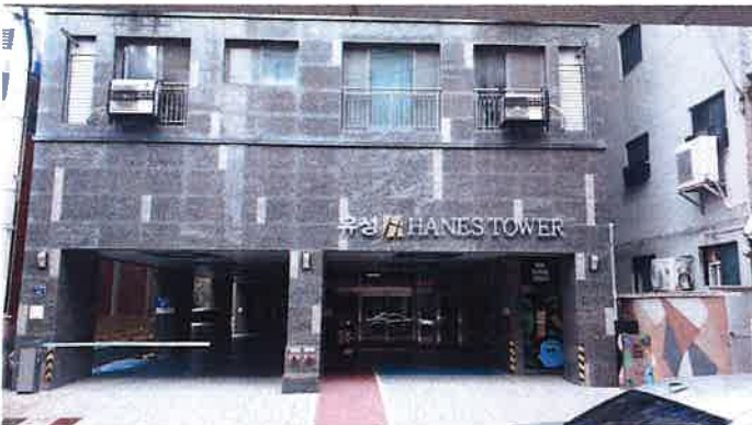
[본건 출입구 전경]
