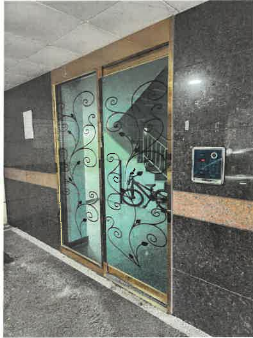
1층 공동 출입문 전경
