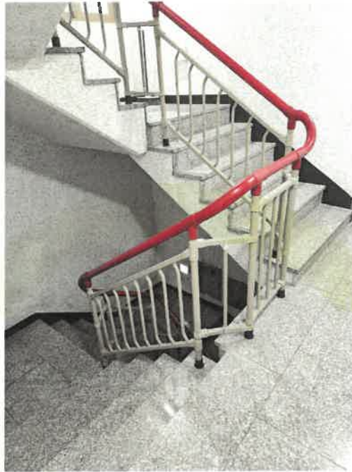
각층 공동 비상계단 전경
