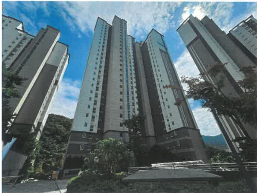
본건 외부 전경
