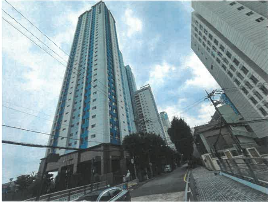
본건 외부 전경
