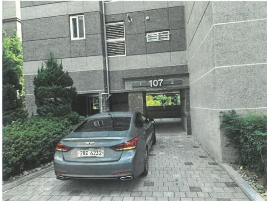
본건 1층 공동출입구
