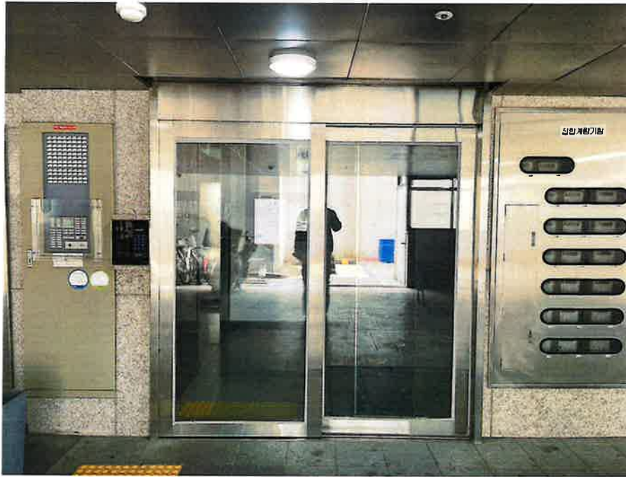
본건 1층 공동현관문
