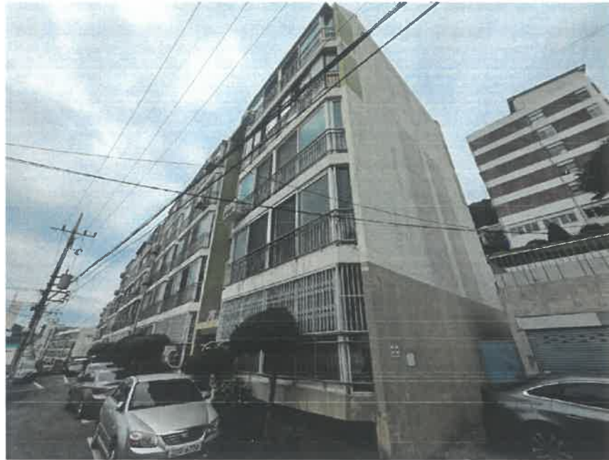
본건 외부 전경
