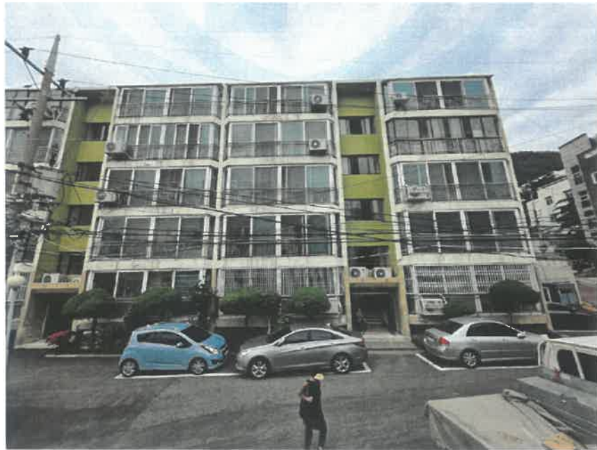
본건 외부 전경
