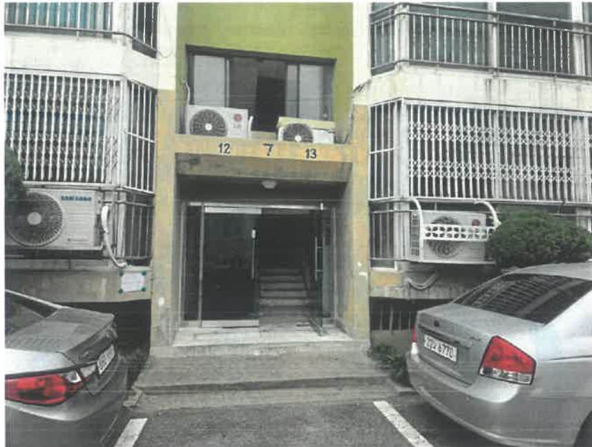
본건 1층 공동출입구
