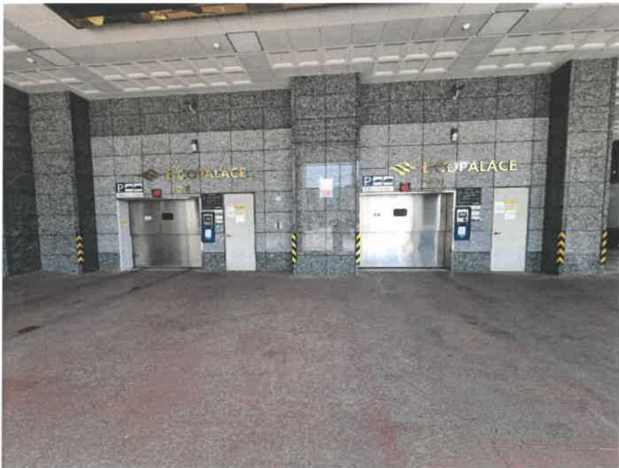
본건 건물 내 기계식주차장 입구
