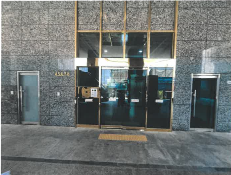
본건 1층 공동출입구
