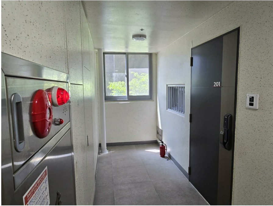
106동 2층 201호 출입전경
