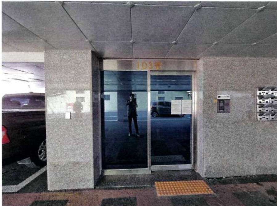
본건(7) 1층 출입구
