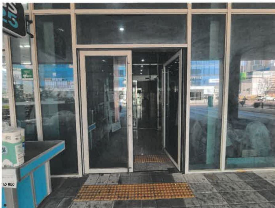
본건 1층 공동출입구
