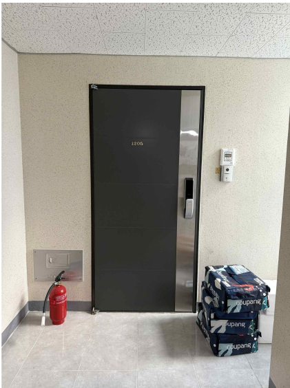
본건 출입문 전경
