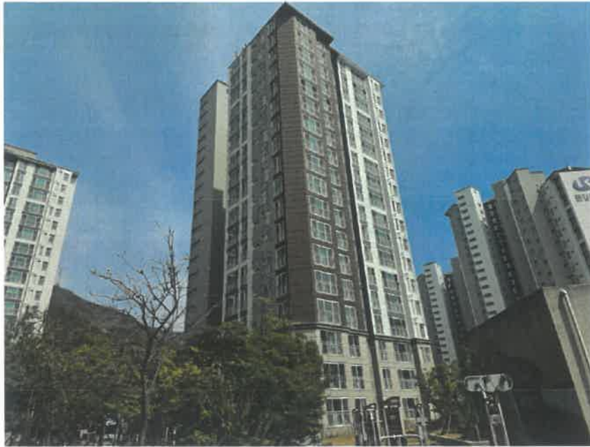
본건 외부 전경
