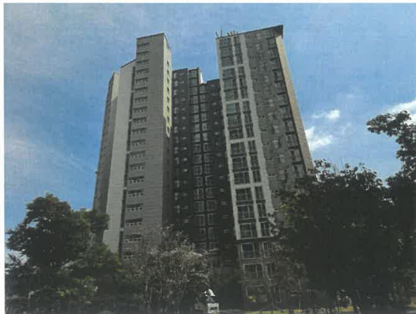
본건 외부 전경
