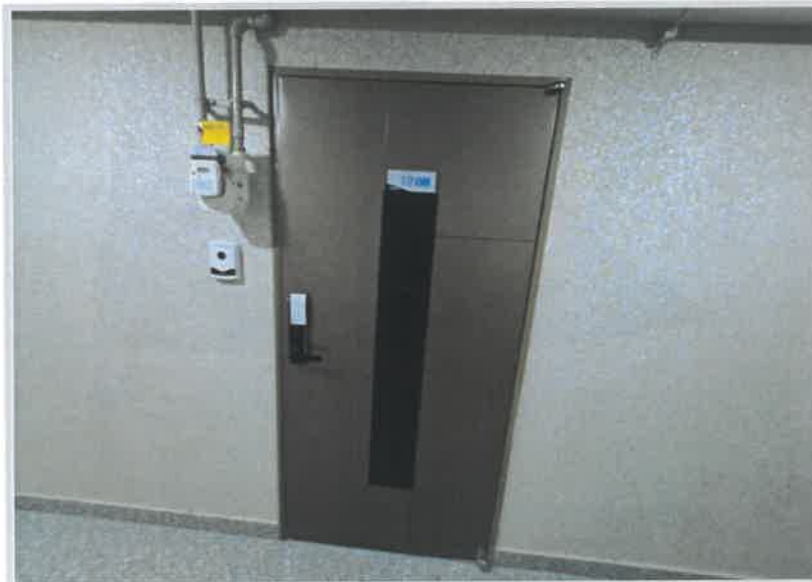
기호(1) 출입문 전경
