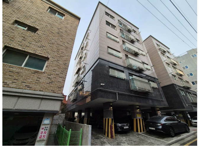
본건 건물 제에이동 측면 전경1
