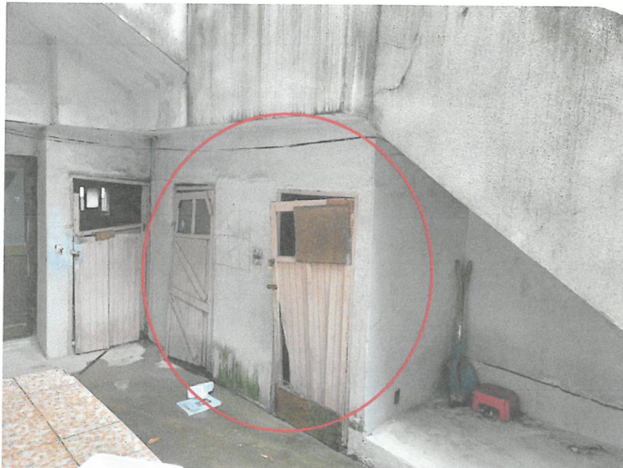
본건 부속건물 전경
