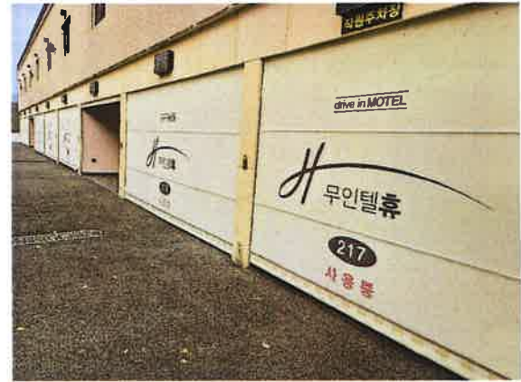
[본건 기호(4) 1층 주차시설]
