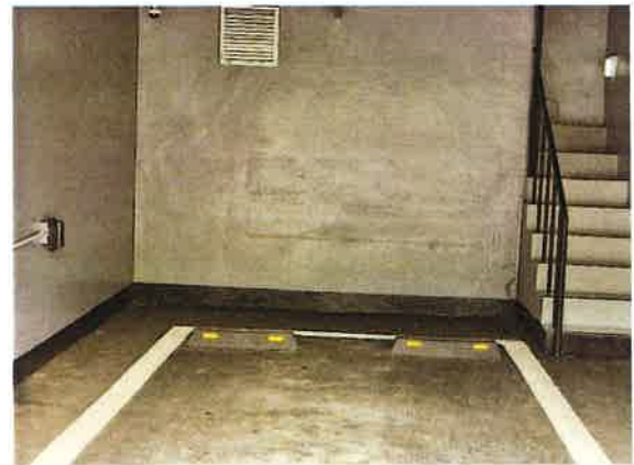
[본건 기호(2) 1층 주차시설 내부]
