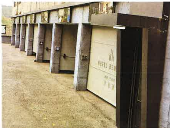
[본건 기호(2) 1층 주차시설]
