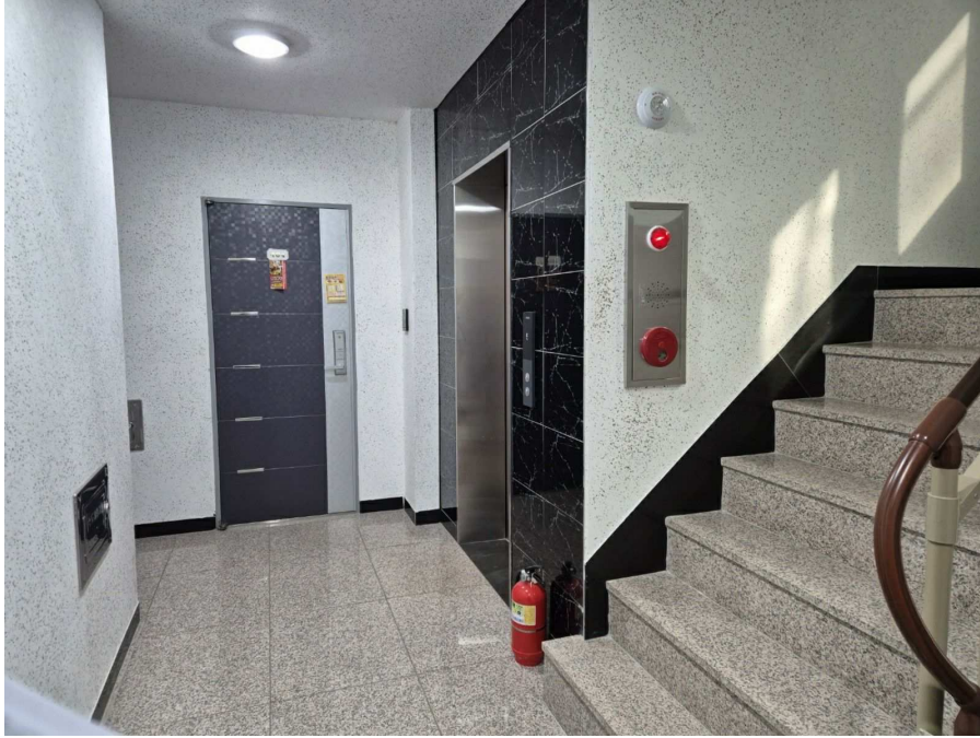
4층 복도 및 및 승강장
