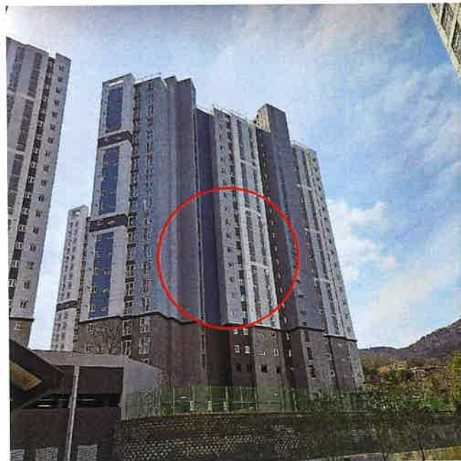
108동 전체 전경(북동측에서 촬영)
