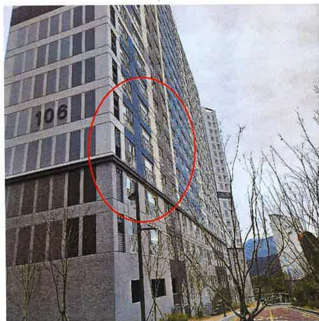
106동 전체 전경(남서측에서 촬영)
