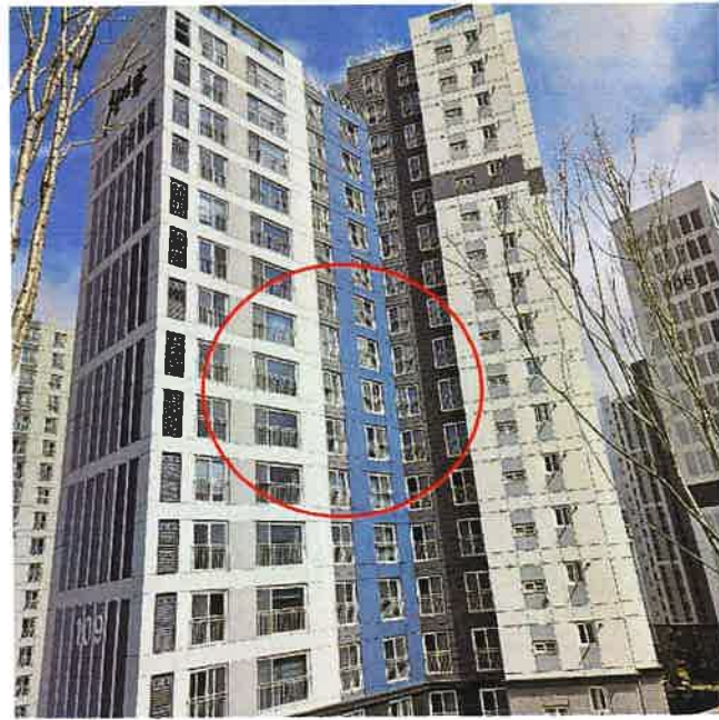
109동 전체 전경(남서측에서 촬영)
