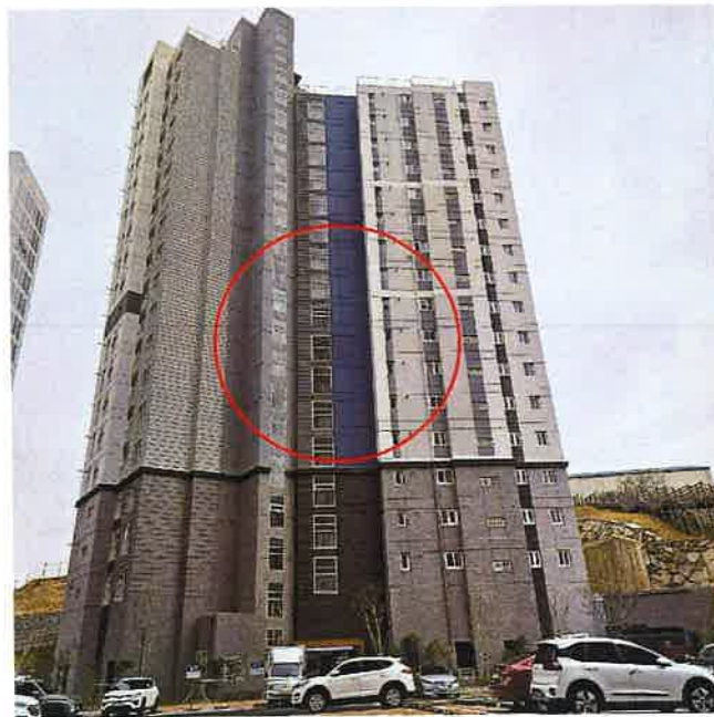
109동 전체 전경(북측에서 촬영)
