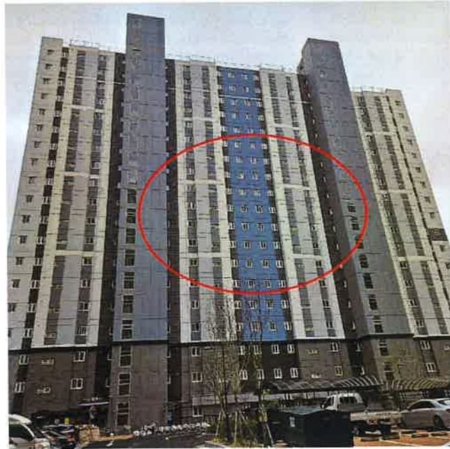
106동 전체 전경(북측에서 촬영)
