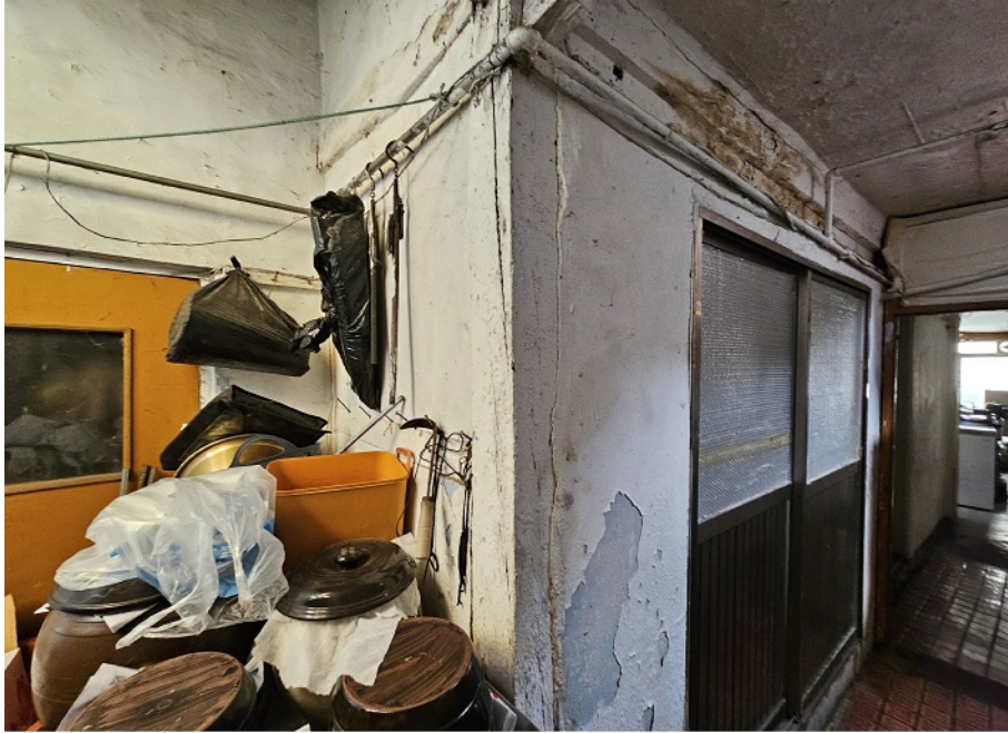
[ 본건 기호(1) 건물 전경 ]
