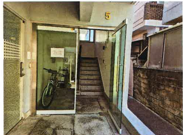
[본건 공동 출입구 전경]
