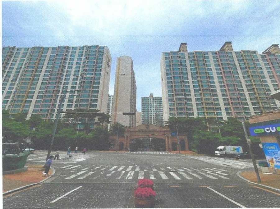
본건소재 단지 전체 전경
