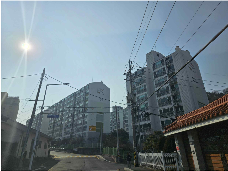
본건 외부 전경
