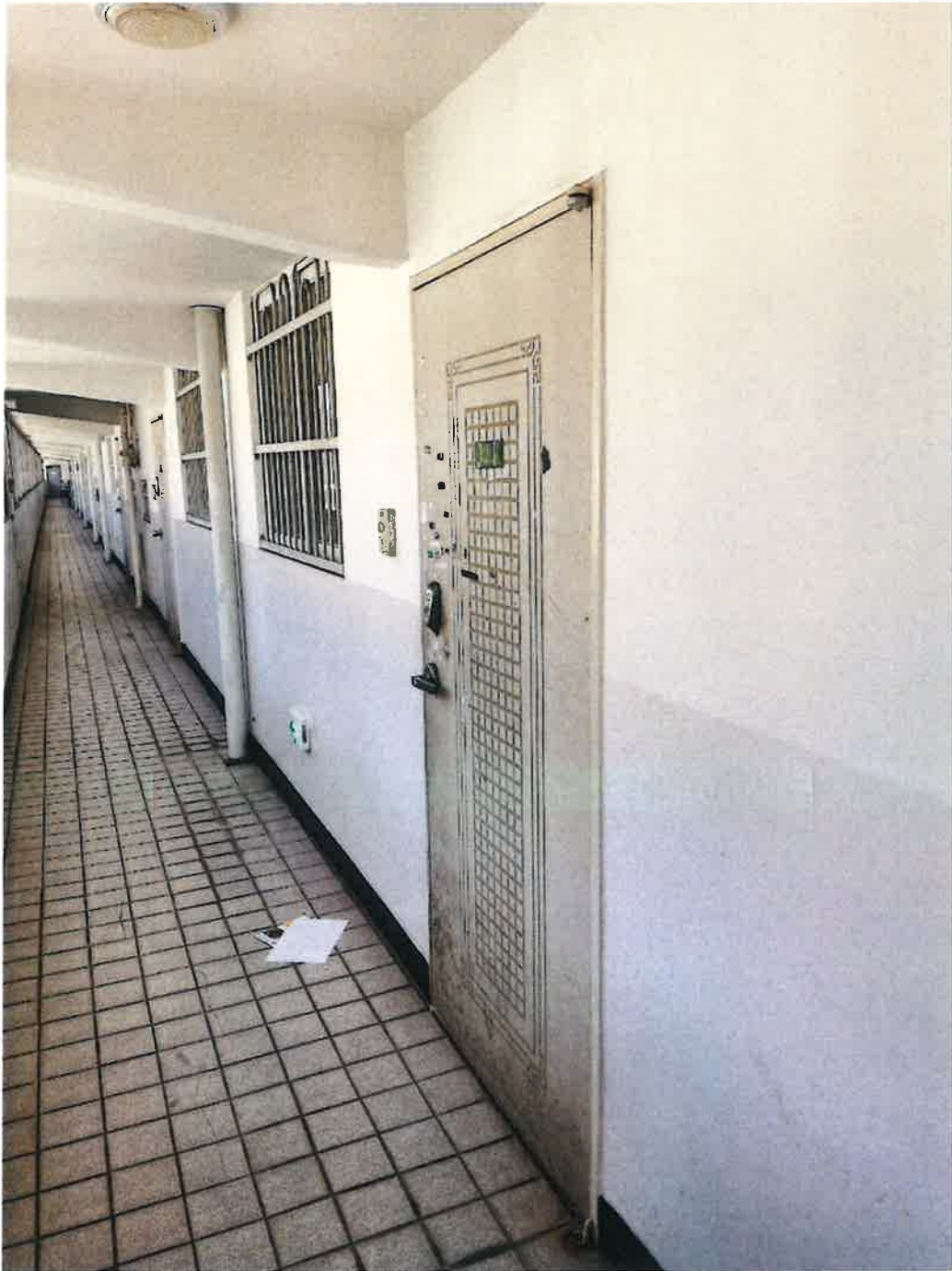
606동 15층 1510호 출입문
