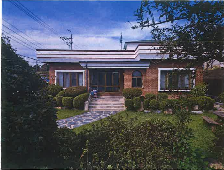
기호(2) 건물 전경
