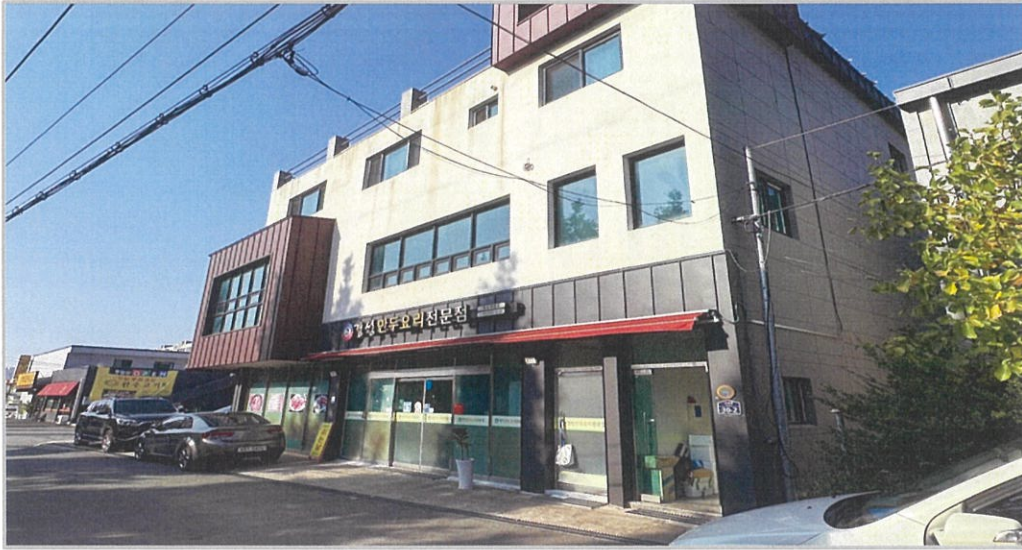
건물 기호 1) 전경
