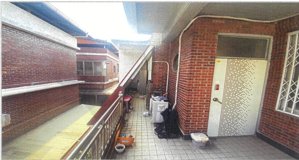
기호 2) 2층 전경
