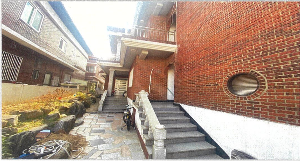
기호 2) 1층 전경
